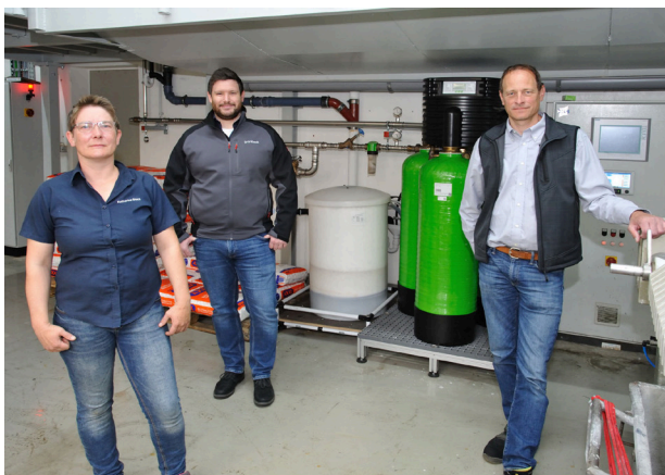
Abbildung 3: Teamarbeit: Katharina Stach, Prozessplanerin (l.), und Thomas Haller, für die Planung und Beschaffung von Produktionsanlagen zuständig (r.) konzipierten gemeinsam mit Grünbeck-Projektleiter Michael Schuldes die Anlage zur Wasserentsalzung. Im Hintergrund der vorgeschaltete Ionenaustauscher zur Enthärtung. Bild: Grünbeck Wasseraufbereitung GmbH
